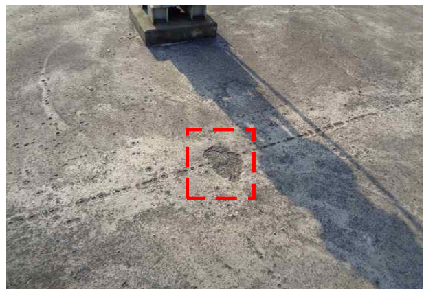
외부 바닥, 콘크리트 파손 (A=0.2m×0.2m)
