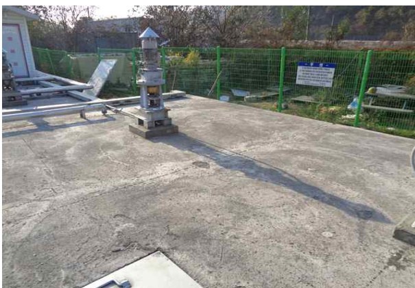
외부 바닥, 콘크리트 파손 (A=0.2m×0.2m)
