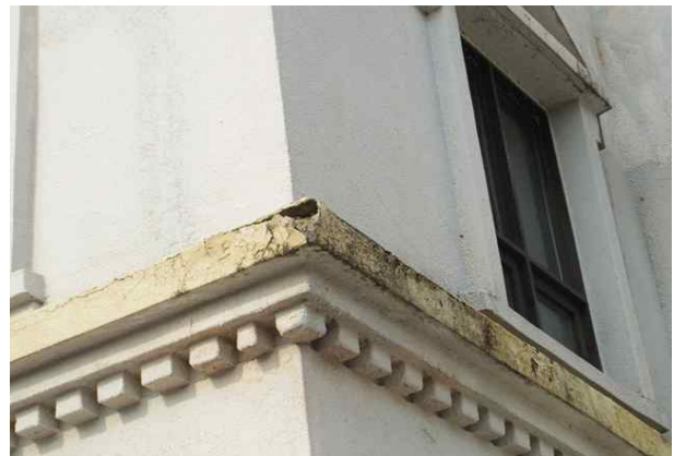
외부 벽체, 콘크리트 들뜸 ( A=2.0m \times 1.0m , 2EA)
