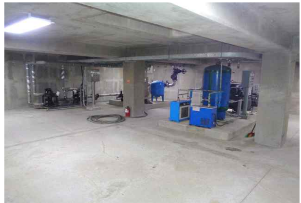
내부 지하3층 전경
