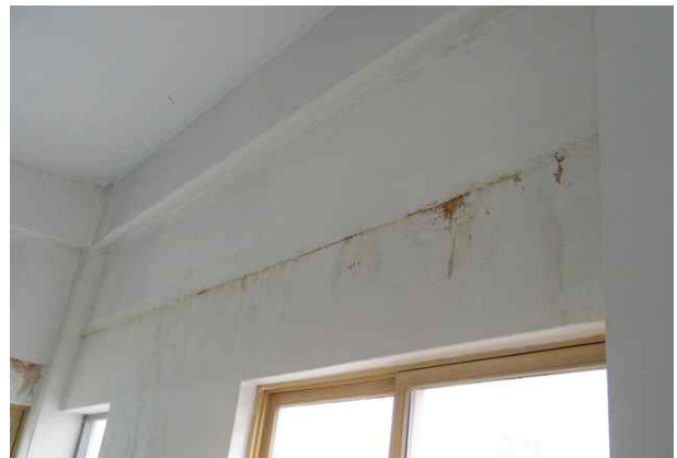
내부 벽체 누수흔적 ( A=5.0\text{m}\times1.0\text{m} )
