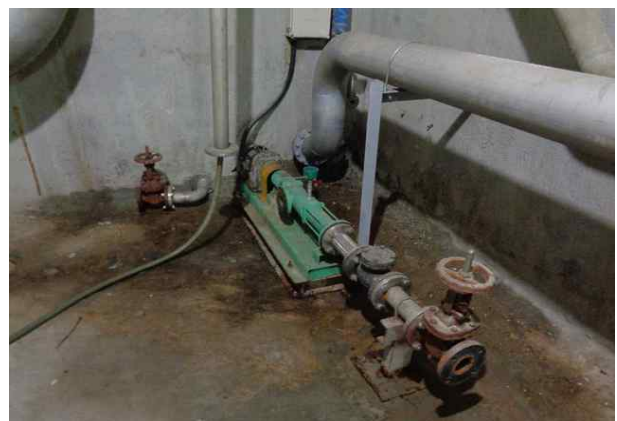
내부 바닥 체수 (A=1.5m×1.5m)
