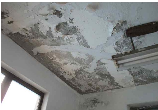
내부 천장 도장박리 및 누수 (A=2.5m×2.5m)
