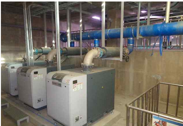
내부 지하1층 전경
