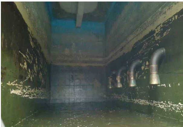
방류조 내부 배수후 외관조사
