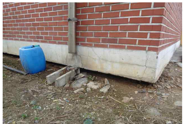
외부 벽체 공동 ( A=15.0\text{m} \times 0.2\text{m} )
