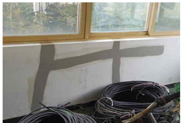
내부 벽체 균열 보수 현황
