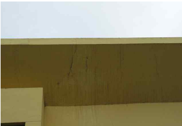
외부 벽체 균열 ( CW=0.1\text{mm} , L=1.0\text{m} , 5EA)
